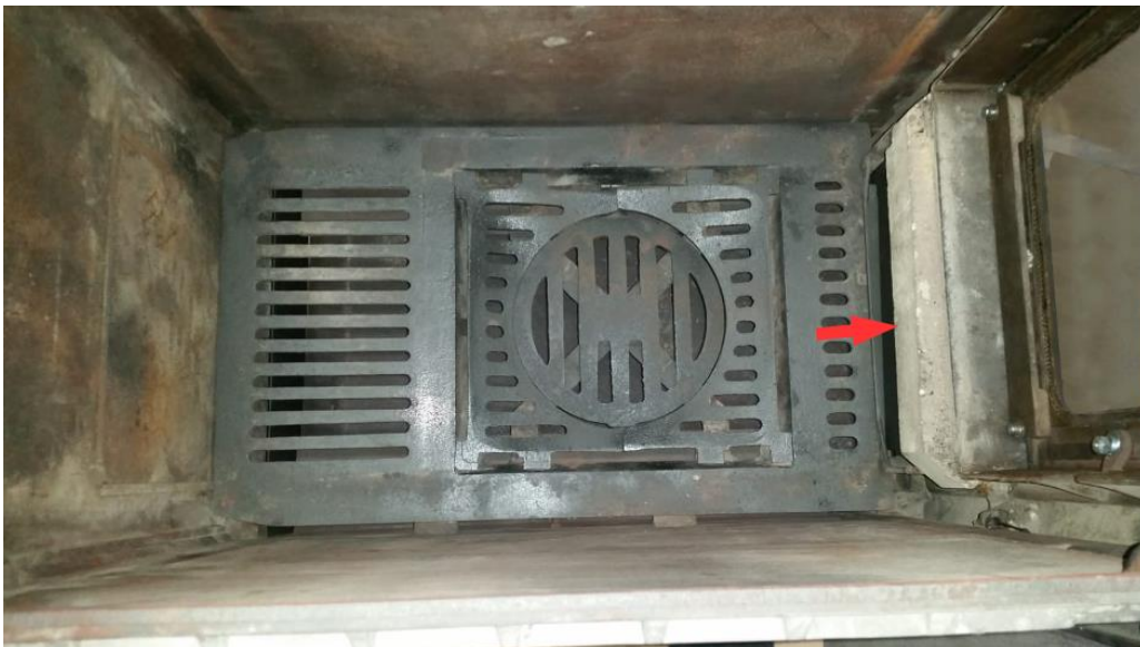
Abb. 10: zuerst den Türriegel mit Schamottemörtel einsetzen(3); alle anderen Teile in nummerierter Reihenfolge trocken einsetzen. Durch das Einsetzen der Schamottesteine in das Heizgerät entstehen hinter den Ecken jeweils Hohlräume; verwenden Sie die mitgelieferte Steinwolle, um diese zu auszufüllen.
