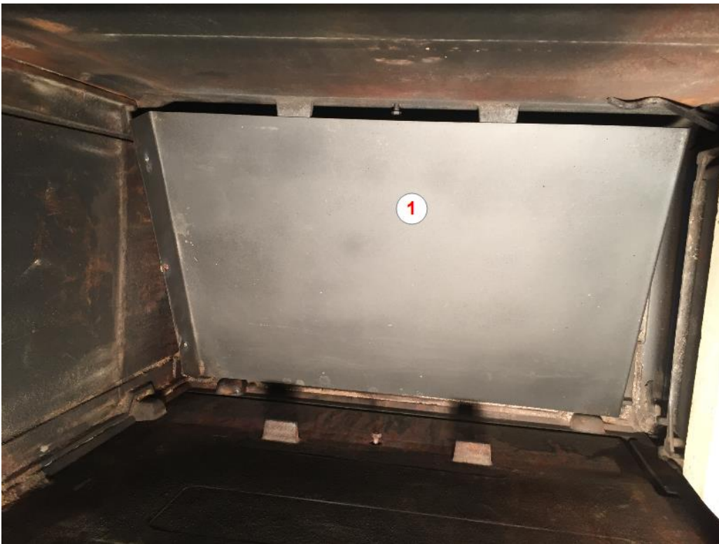
Abb. 4: Bodenblech (1) einlegen, so dass der Winkel an der Rückwand nach oben zeigt. Durch Auflage des Bodenbleches auf den 4 Gussnoppen auf dem Gussboden entsteht ein gewollter Abstand vom Gussboden zum Bodenblech (1).
